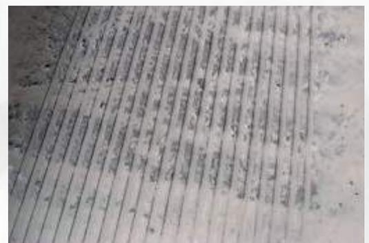
Rillenprofil in einer Betonfläche
